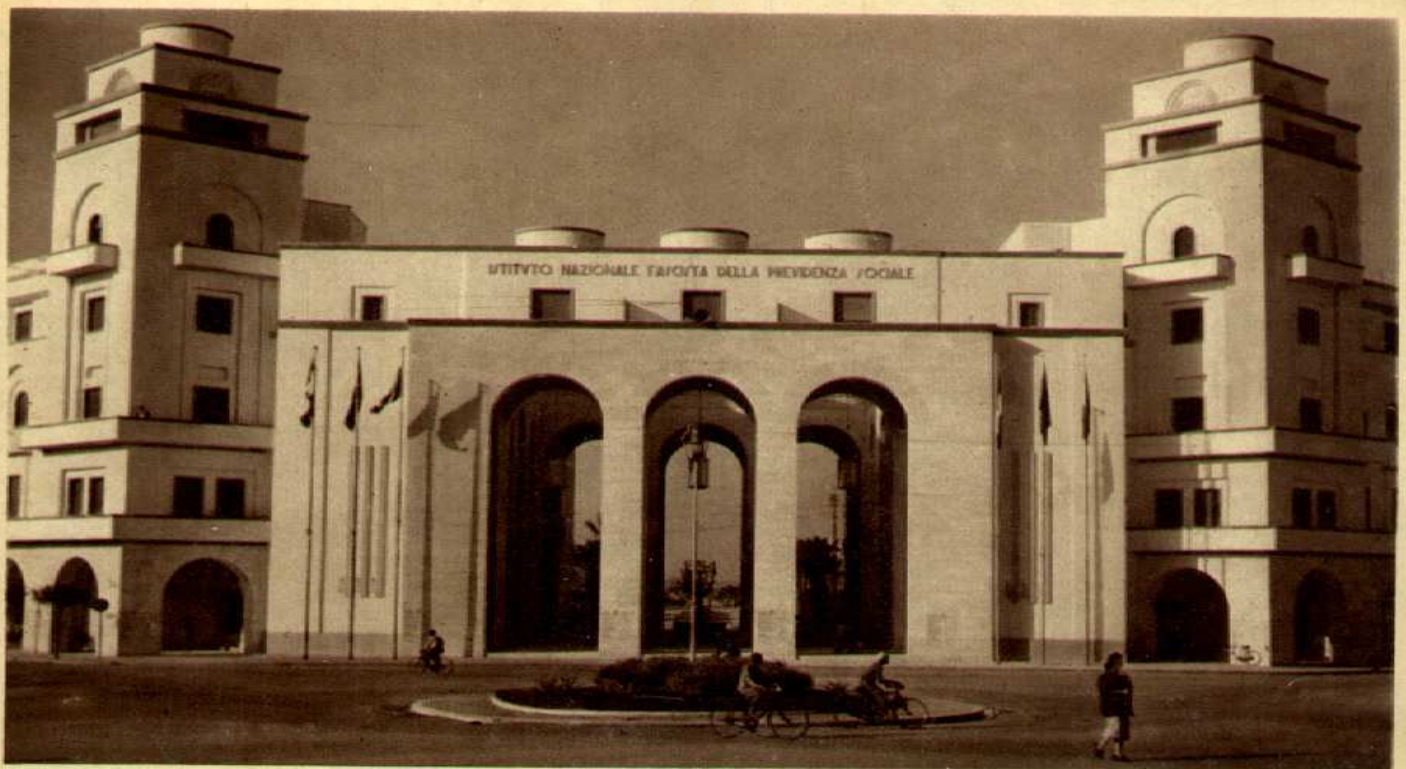
TRIPOLI - Palazzo Istituto Previdenza Sociale.
